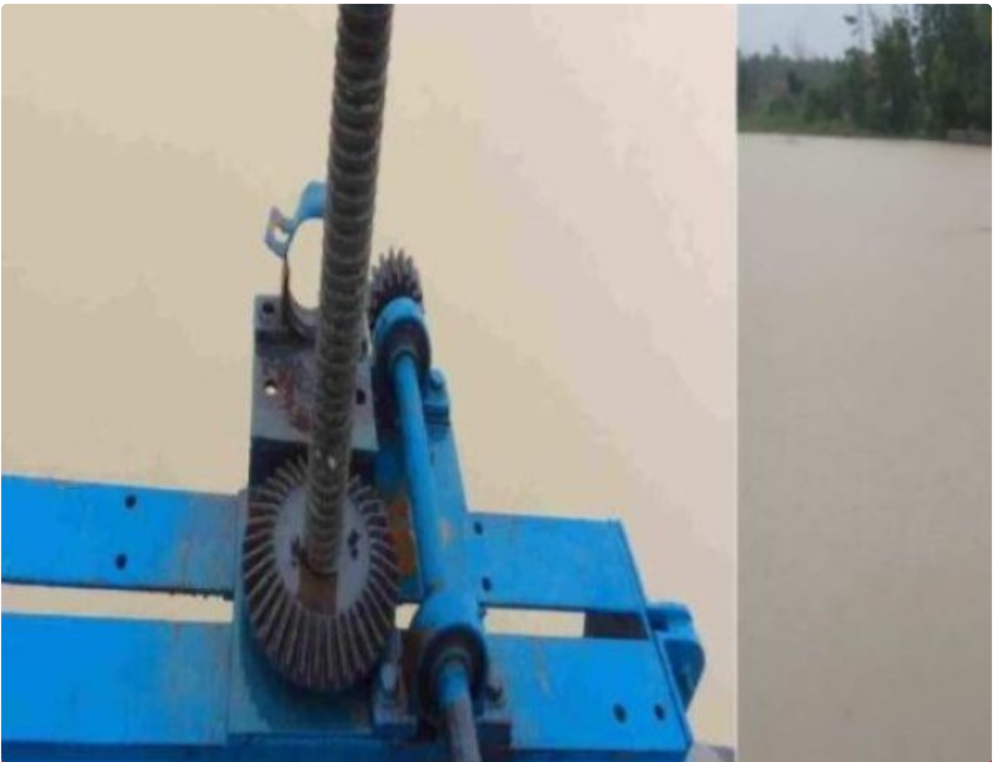
Pintu air Albaret Simpang Mesuji
